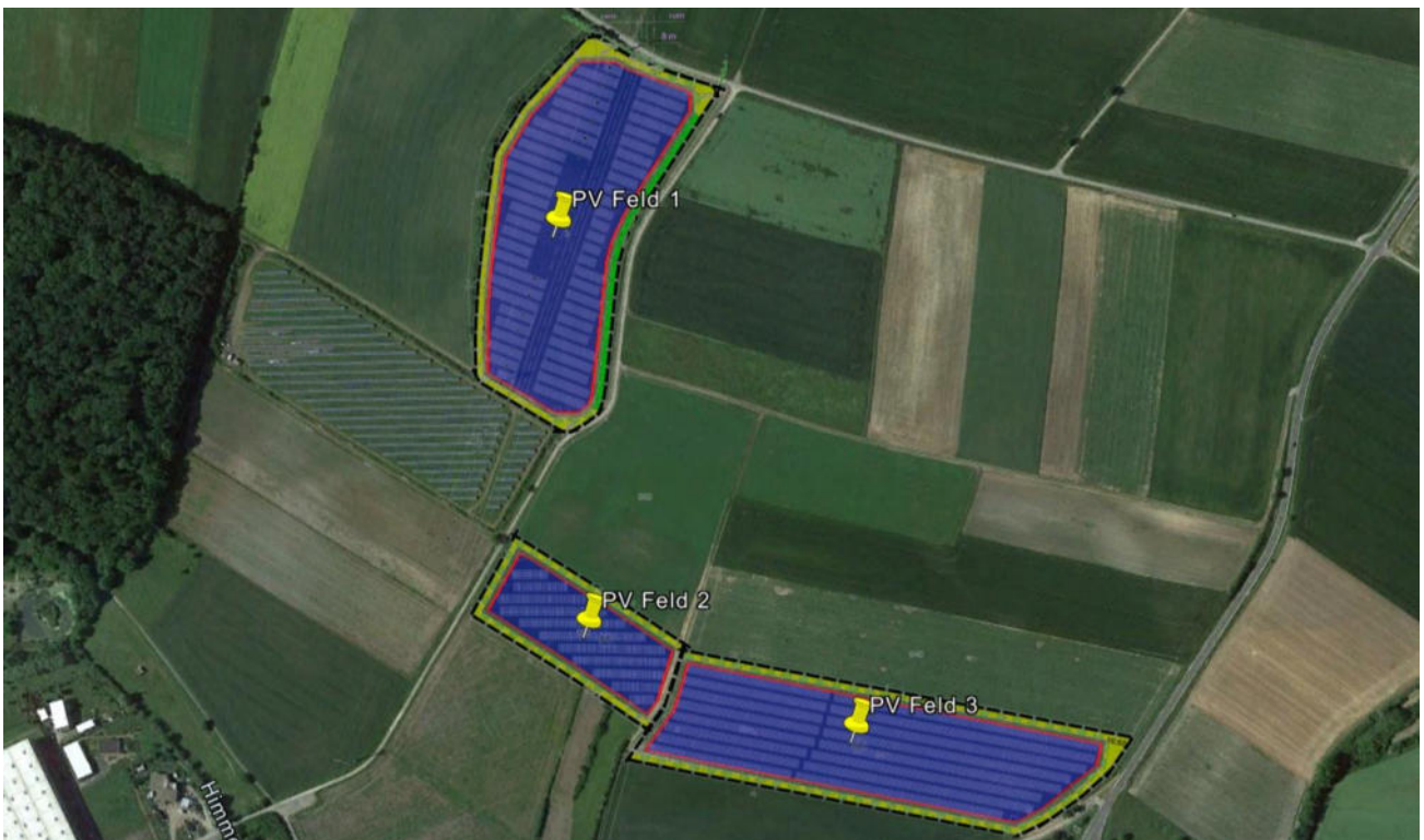
Bild 2.1.3: Detailansicht der PV Flächen (Quelle: Google Earth/SolPEG, Nordausrichtung)
