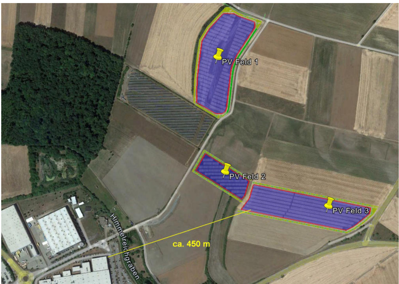
Bild 2.2.1: Gebäude südwestlich der PV Anlage (Quelle: Google Earth/SolPEG)
