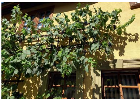
Fassade Seel: Nicht nur optisch ein Hingucker sondern auch noch schmackhaft: Rebstöcke als Fassadenbegrünung.
