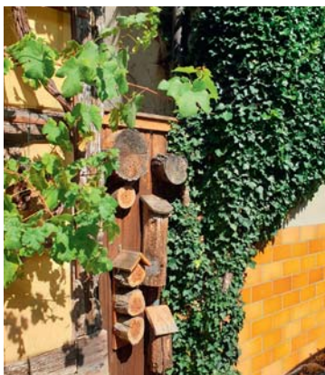
Fassade Schenk: Kombination aus Fassadenbegrünung und Insektenhotel. Efeu- oder Rebstöcke kühlen im Sommer durch die Abgabe von Feuchtigkeit über die Blattoberfläche und brechen im Winter den kalten Wind.
